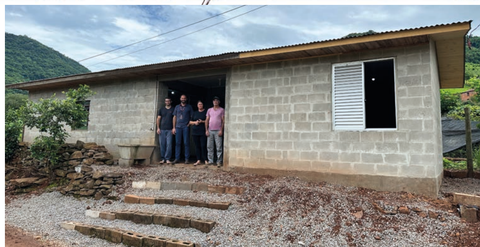
FAMÍLIA GABARDO de Vale Aurora/Bento Gonçalves investiu R$ 50 em melhorias na alojamento, refeitório e no novo depósito de insumos.
