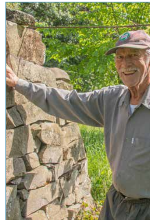
▲ OCANTONAL de pedras utilizado para segurar a cordoalha que sustenta os fios de condução da videira, foi construído há 40 anos pelo seu Dornelio.
